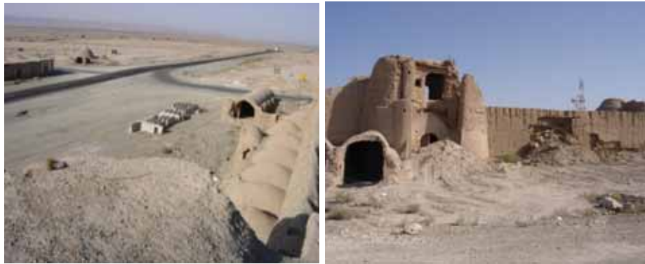
تصاویر شماره ۵ و ۶: نمای جنوبی، در ورودی بازار آب انبار دو در کاروانسرای عبدل آباد (Authors)
