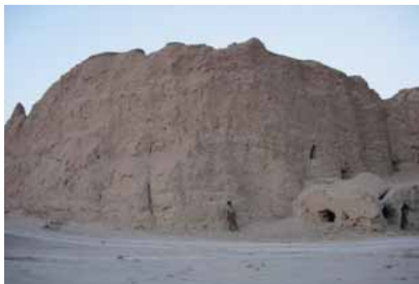
تصویر شماره ۴: نمای غربی دژ ده نمک و ارتفاع بلند باروی آن (Authors)
